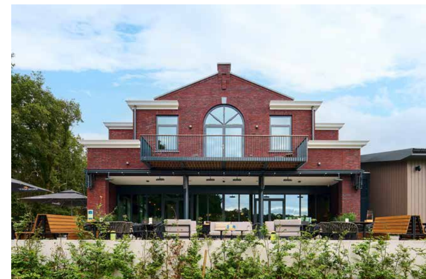
Naast de stallen, de rijhallen en de buitenpistes springt ook het entreegebouw met onder meer kantoren, restaurant en appartementen in het oog.
